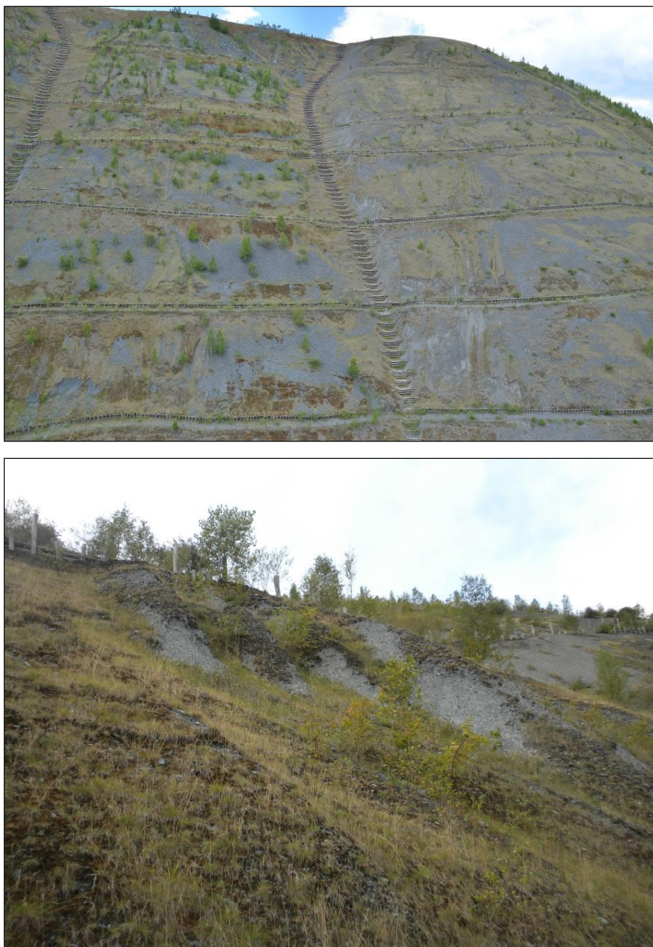
Figura 26 – Vista frontale e dal basso dei fenomeni erosivi e di danneggiamento della copertura vegetale sul lato ovest del corpo di discarica
