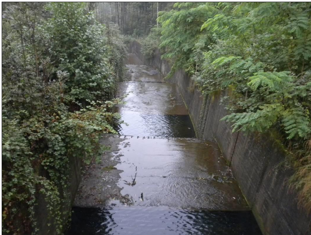
Figura 8 – Particolare del canale artificiale di deviazione delle acque della testata del Rio Fandaglia verso l'alveo del Rio Fornaci
